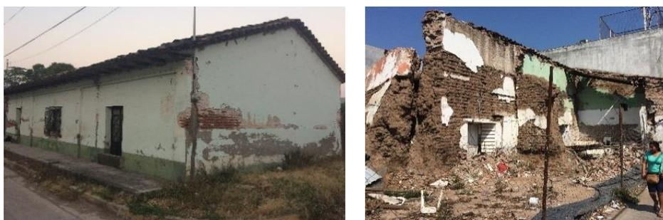
**FIGURA 3.** Problemáticas identificadas en las viviendas en el Istmo de Tehuantepec después de los sismos del 2017
