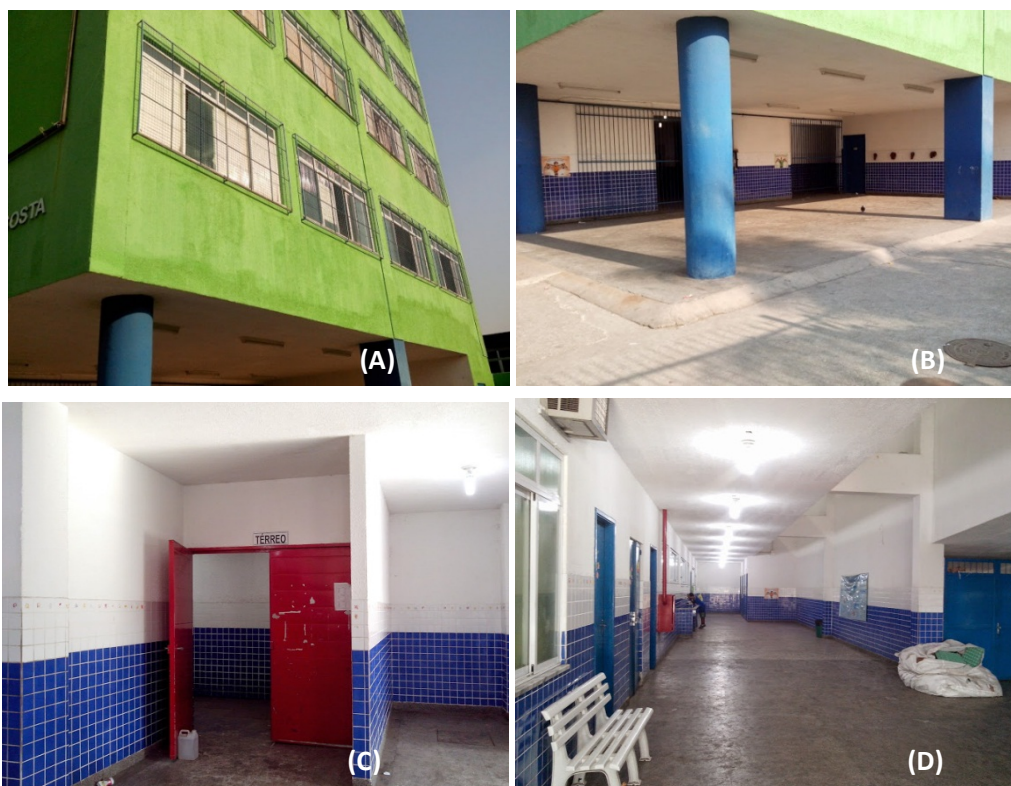
FIGURA 1. Edificação da unidade escolar pesquisada e suas respectivas áreas. (A) Fachada do prédio da unidade escolar. (B) Pátio externo, (C) entrada (rampa para acesso aos andares superiores) e (D) Pátio interno. As fotos foram obtidas fora do horário das atividades acadêmicas e após a atividade de limpeza.
